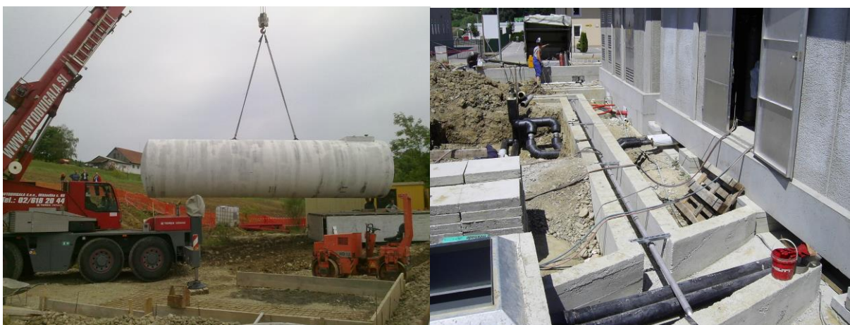
Gradnja OVE elektrarne
